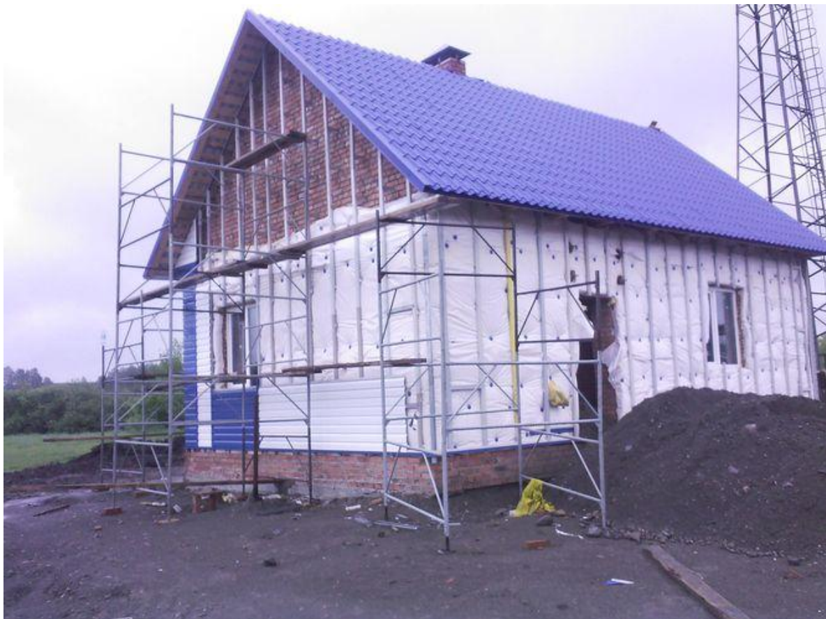
Фото 1. Пример кирпичной кладки с применением противоморозной добавки «Мобет» марки 3 «эконом» при отрицательных температурах.
